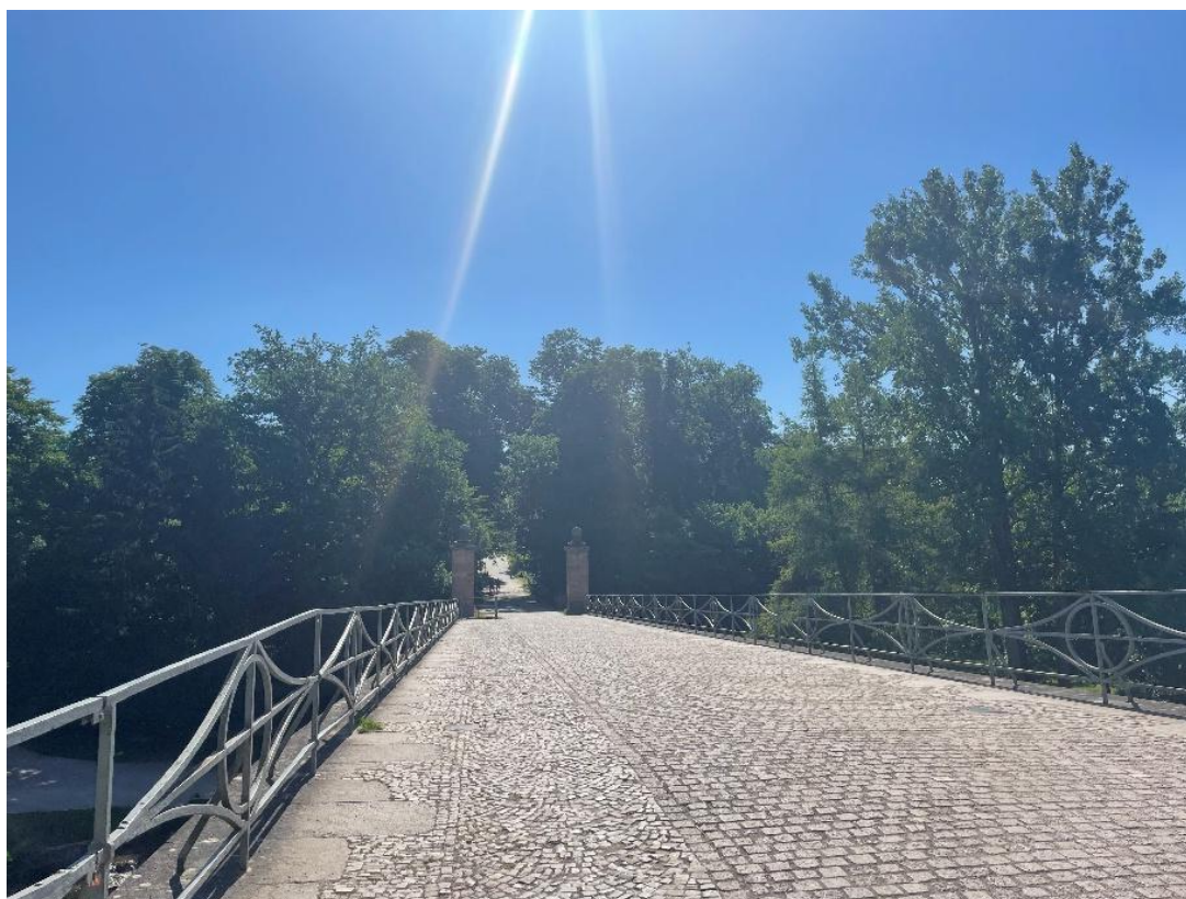
Abbildung 5: Zugang mit Treppen: Sternbrücke.
