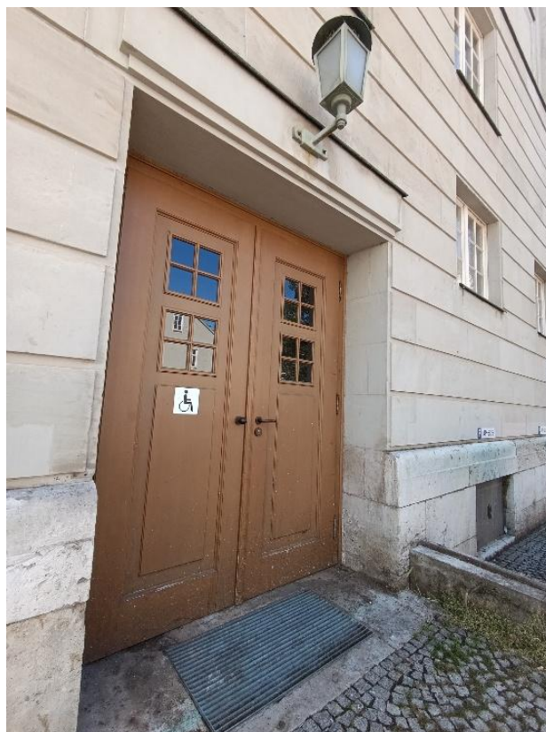
Abbildung 5: Tür des Rollstuhleingangs.
